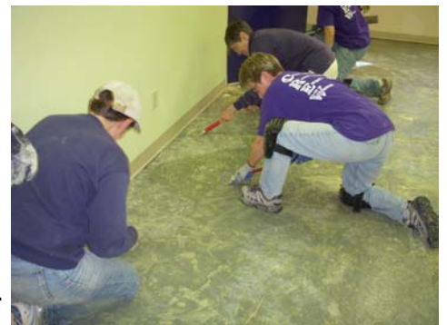
Preparando el Piso (Preparing the Floor)
