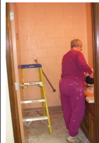
Pintando el Baño (Painting the Bathroom)
