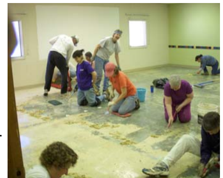
Preparando el Piso (Preparing the Floor)
